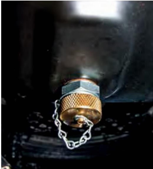
76. ábra. Olajleeresztő szelep
